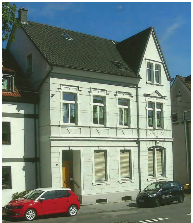
Hasselstr. 83, Zustand des Hauses September 2016
